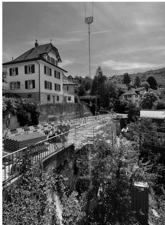
Reparaturarbeiten an der Hertensteinstrasse: Komplex.
