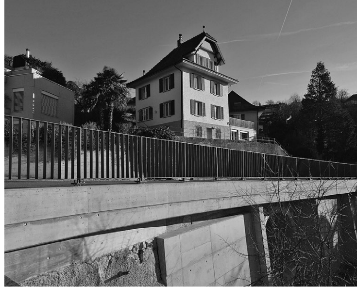
Kragplatte an der Hertensteinstrasse mit neu-altem Geländer: Angepasst und wiederverwendet.
